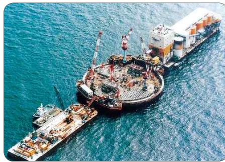
(b) 주탑기초 시공
