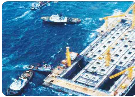
(b) 앵커리지 시공
