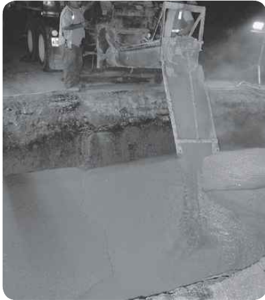
〈그림 2〉 교량보수, TxDOT
